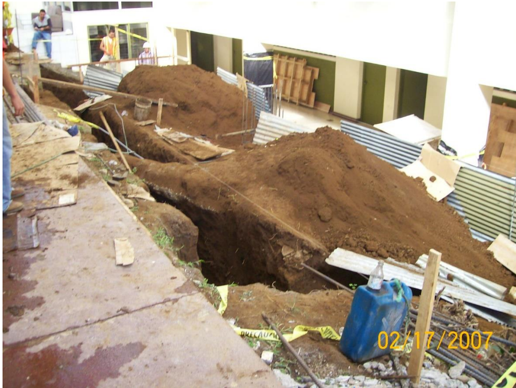
Centro Regional de San Carlos. El antes. Construcción de la rampa de accesibilidad a la segunda planta del edificio.
