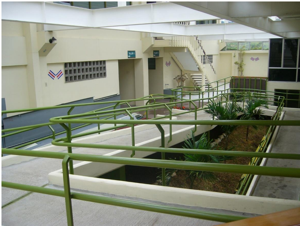
Centro Regional de San Carlos. El después. Rampa de accesibilidad a la segunda planta ya construida del edificio.
