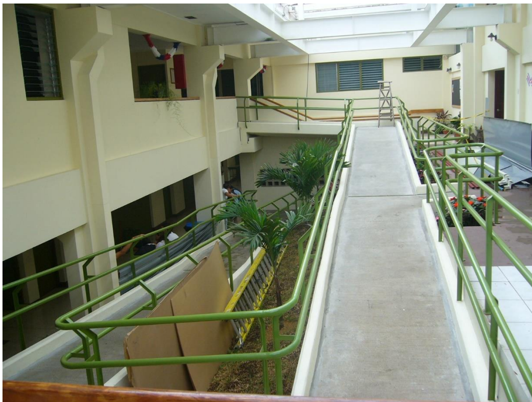
Centro Regional Polivalente de San Carlos. Rampa de accesibilidad para Personas con discapacidad para acceder área administrativa y aulas en el segundo piso del edificio.
