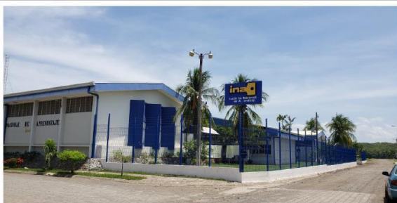
Malla instalada costado Sur este vista externa
