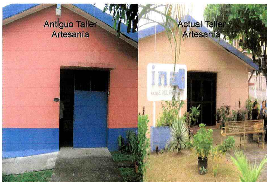
Foto 2 Construcción de taller artesanal
