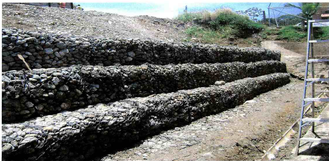
Figura 4 Construcción del muro de gaviones
