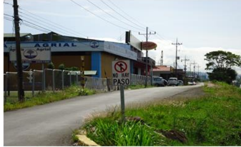
FOTOGRAFIA N° 5: Vista parcial de la vía paralela a la Carretera Bernardo Soto, pocos metros al este del Hotel Aeropuerto. Nótese que no se permite el paso en sentido este-oeste.
