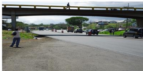
FOTOGRAFIA N° 21 Vía de acceso sobre la Carretera Bomedio Soto, entre una Villa Bonita con San Antonio del Tajar, Alajuela. En el sector inferior izquierdo se observa el acceso provisional a la vía paralela a la Carretera Bomedio Soto.
